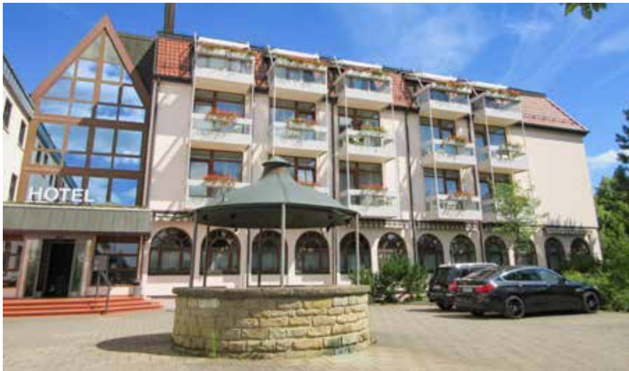
Das Hotel Häffner in Bad Rappenau profitiert von der Wärmeversorgung, die jetzt auch Solarthermie einbindet.
