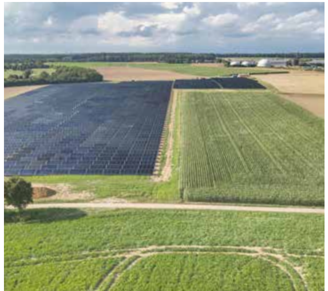
Im Vordergrund ist das derzeit größte Solarthermiefeld Deutschlands mit einer Bruttokollektorfläche von knapp 29.000 m 2 zu sehen, im Hintergrund eine der Biogasanlagen des Unternehmens Bauer.
