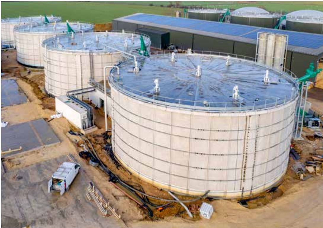
Im Rohbau gut zu erkennen: die Betondecken der Fermenter von Mepal III.
