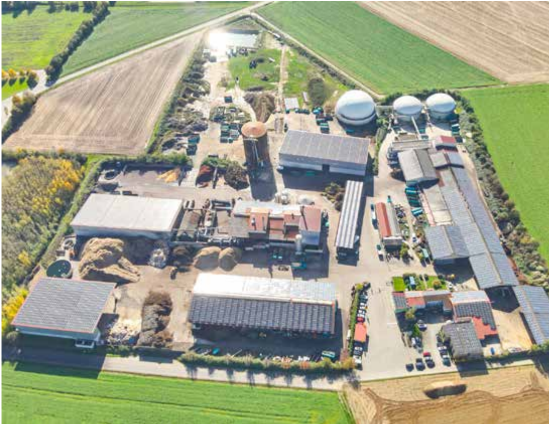
Auf den Dachflächen des Unternehmens Bauer sind 4 Megawatt PV-Stromleistung installiert.
